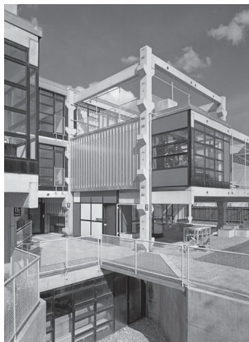
Abb. 5 München, Wohnanlage Genter Straße, 1969–71, Arch. Doris Thut, Ralph Thut, Otto Steidle, Ansicht (Fotografie: Klaus Kinold, 1972).
