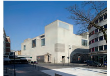
Abb. 13 Außenansicht des Kolumbas von Peter Zumthor in Köln
