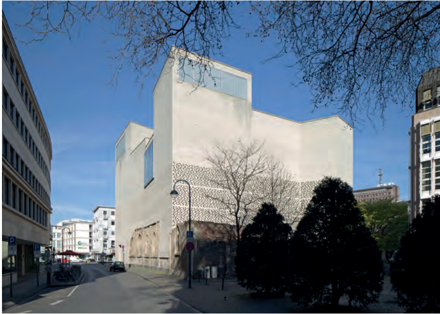
Abb. 12 Außenansicht des Kolumbas von Peter Zumthor in Köln
