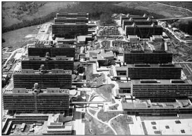
Abb. 1 Rational organisierte Großform im Bau. Ruhr-Universität Bochum, Helmut Hentrich, Hubert Petschnigg und Partner, ab 1962. Luftbild der Gesamtanlage. Tilemann 1972.
