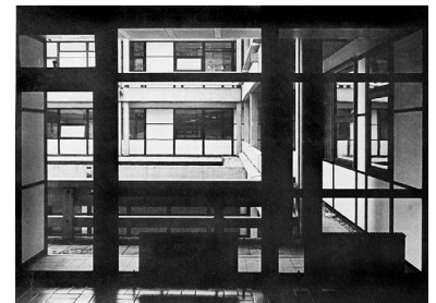
Abb. 4 Architektur schien sekundär. Gebaute Realität des Marburger Systems . Universität Marburg 1971.
